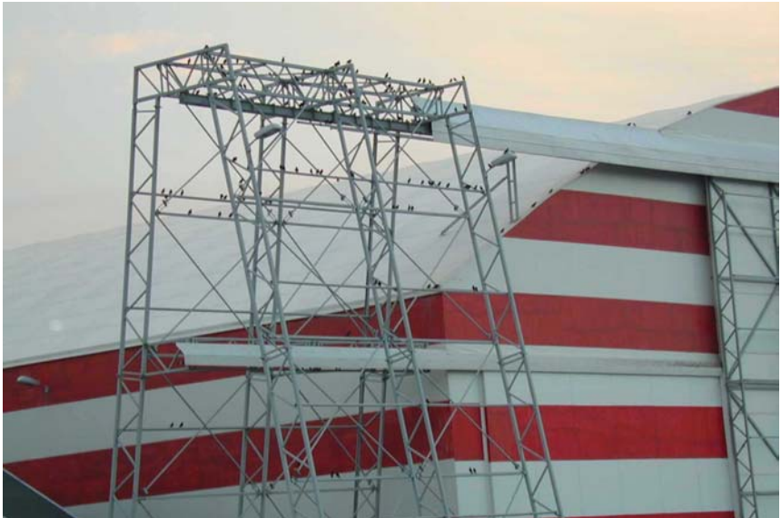
Abb. 1: Hirtenmainas auf der Torführung der Wartungshalle
