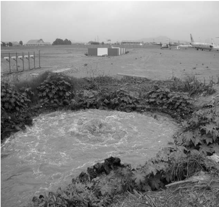
Abb. 3: Am Südennde der Start- und Landebahn tritt ein Abwasserkanal zu Tage. Links ist die ILS-Anlage zu erkennen. Oben rechts abgestellte Flugzeugwracks
