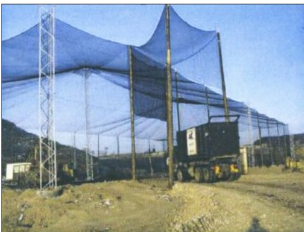
Müllhalden in der Nähe von Flughäfen können mit Netzen überspannt werden, um flugsicherheitsrelevante Vögel fernzuhalten.
