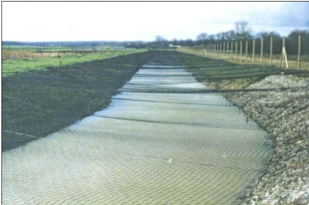
Von Bewuchs befreite und mit Netzen überspannte Entwässerungskanäle sind für Vögel unattraktiv und haben gleichzeitig eine bessere Entwässerungsleistung.
