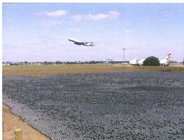
Wasserrückhaltebecken können mithilfe von Netzen oder, wie in diesem Fall, mithilfe treibender Bälle von Vögeln freigehalten werden.
